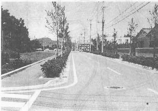
▼今の道路の様子（小出発電所付近）
